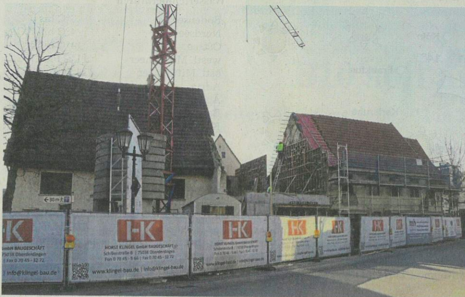
Im Rohbau: Nach dem Abbruch einer Scheune zwischen den beiden Gebäuden in der Brettener Straße in Oberderdingen entsteht dort ein Neubau. Foto: Barbara Lohner
