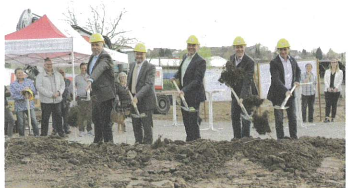
Bild: (v.l.n.r.) Architekt Günther Meerwarth, Bürgermeister Thomas Nowitzki, Generalunternehmer Peter Klingel von der Firma Klingel GmbH, Bauleiter Renato Recchia
